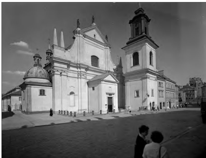
Kościół św. Jacka (wzniesiony w latach 1604-1639 według projektu Jana Baptysty Trevana) i klasztor Dominikanów z lat 1639-1651. Restaurację elewacji kościoła przeprowadzono w 1958 r., a wnętrz w 1968 r. Klasztor odbudowano w latach 1947-1960 pod kierunkiem B. Zborowskiego, 1979, fot. J. Langda, ze zbiorów Instytutu Sztuki PAN
