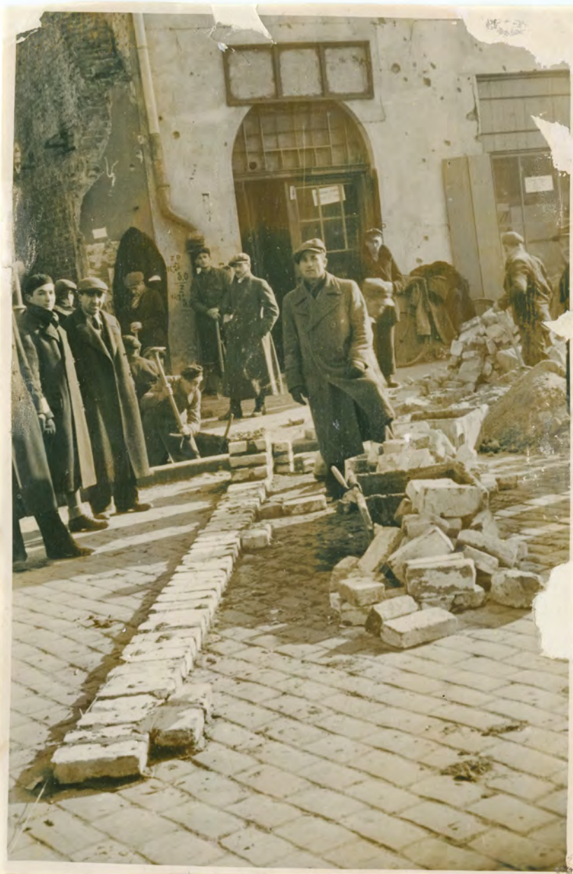
Budowa muru getta na placu Żelaznej Bramy, ze zbiorów Archiwum Państwowego w Warszawie (72/1624/29)
