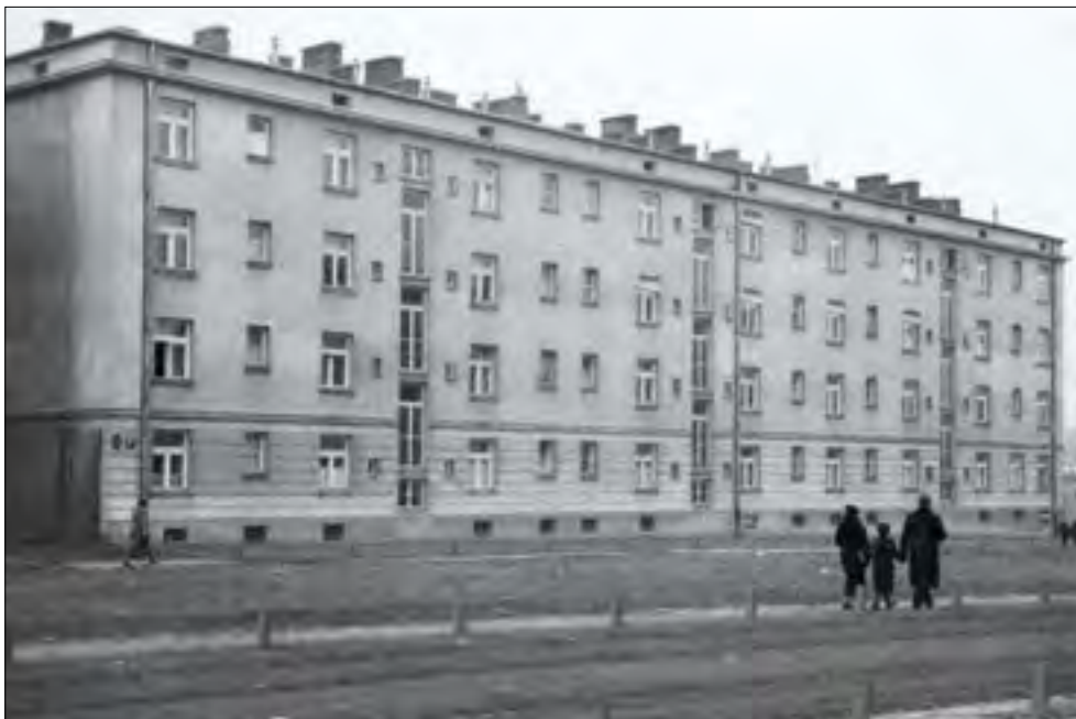
Budynek Warszawskiej Kooperatywy Mieszkaniowej „Fenix” przy ulicy Mickiewicza 31, 1937, ze zbiorów APW (Akta Miasta Warszawy. Referat Gabarytów, sygn. 4623)
