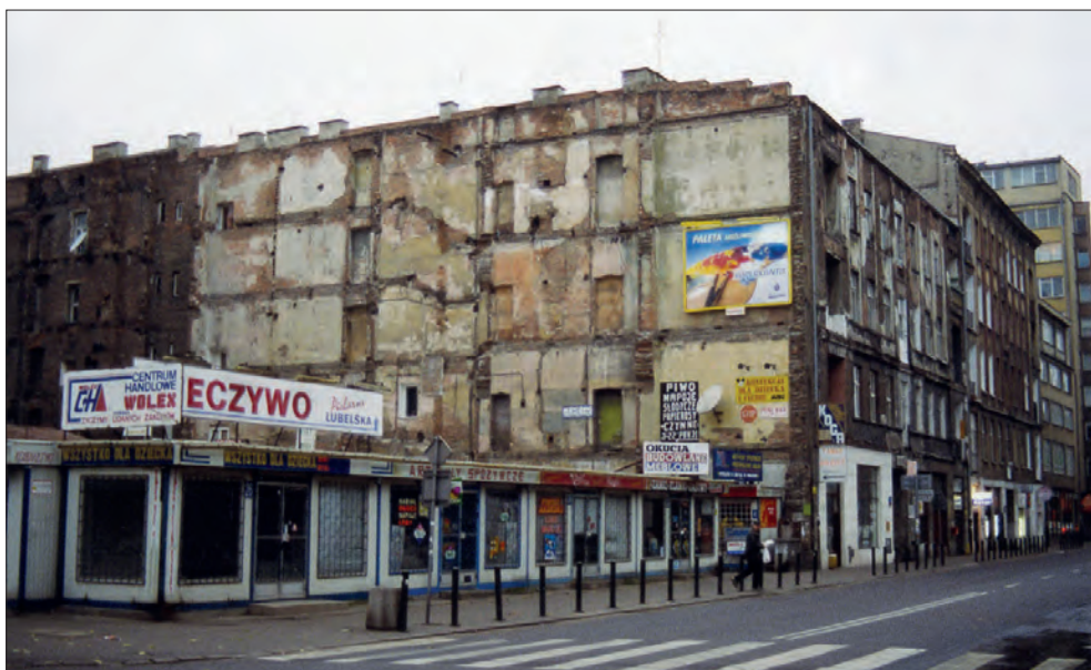
Róg ulicy Żelaznej i Siennej – pawilony handlowe przy Żelaznej 41, dalej kamienice przy Żelaznej 43 i 45 oraz biurowiec przy Pańskiej 73, 1993, fot. K. Ołpiński
