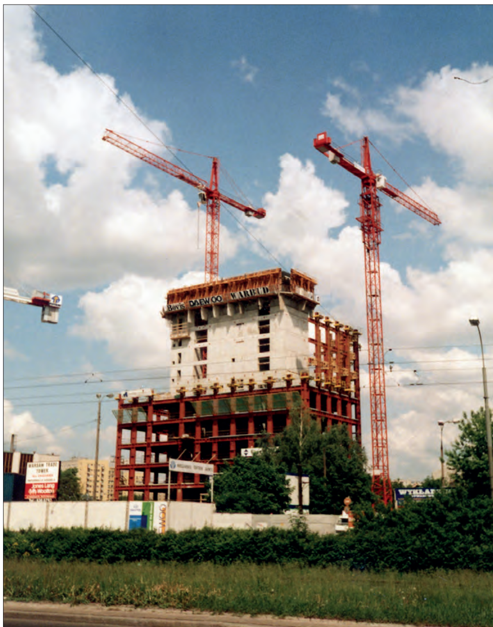
Budowa pierwszego wieżowca na Woli – Daewoo (obecnie Warsaw Trade Tower) przy ulicy Chłodnej 51. Przez długi czas był najwyższym budynkiem w Warszawie (208 m wysokości całkowitej), tuż po Pałacu Kultury i Nauki, 1998, fot. K. Olszak
