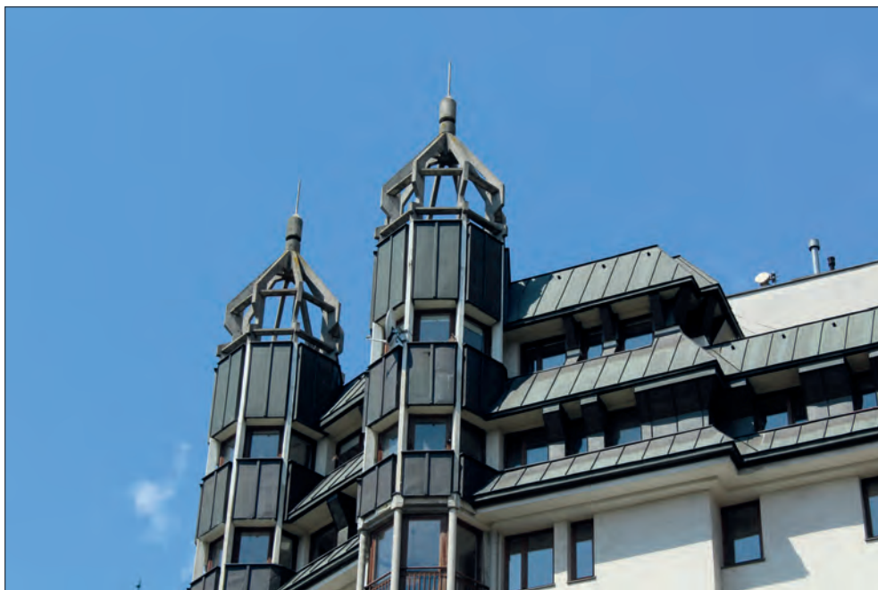
Blok przy ulicy Twardej 44, detal, 2019, fot. P. Jastrzębska
