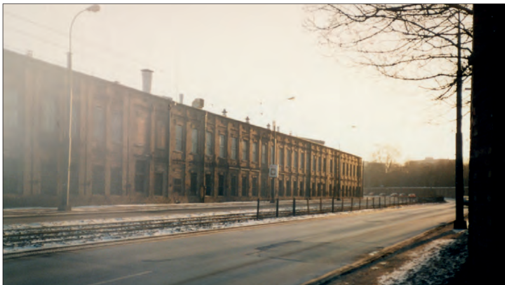
Nieistniejące budynki dawnej Fabryki Garbarskiej Braci Pfeiffer przy ulicy Okopowej 58/72, 1997, fot. D. Olszak, Społeczne Archiwum Warszawy
