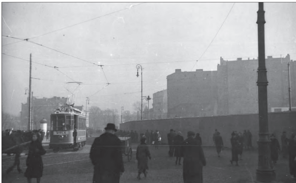
Mur getta przebiegający przez plac Żelaznej Bramy, ok. 1940-1941, fot. NN, ze zbiorów Muzeum Warszawy (sygn. 22641)
