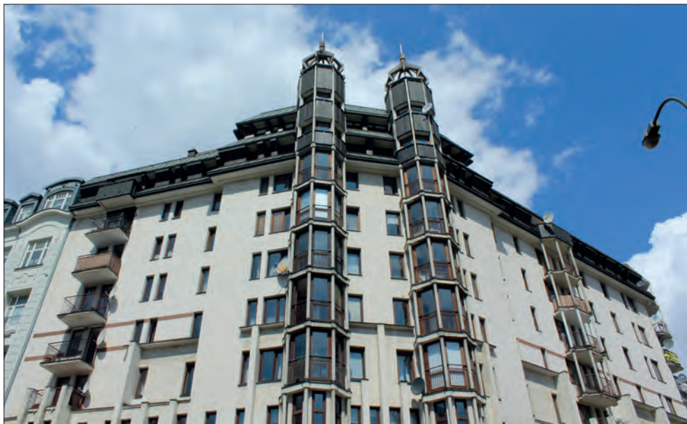
Blok przy ulicy Twardej 44, detal, 2019, Fot. P. Jastrzębska
