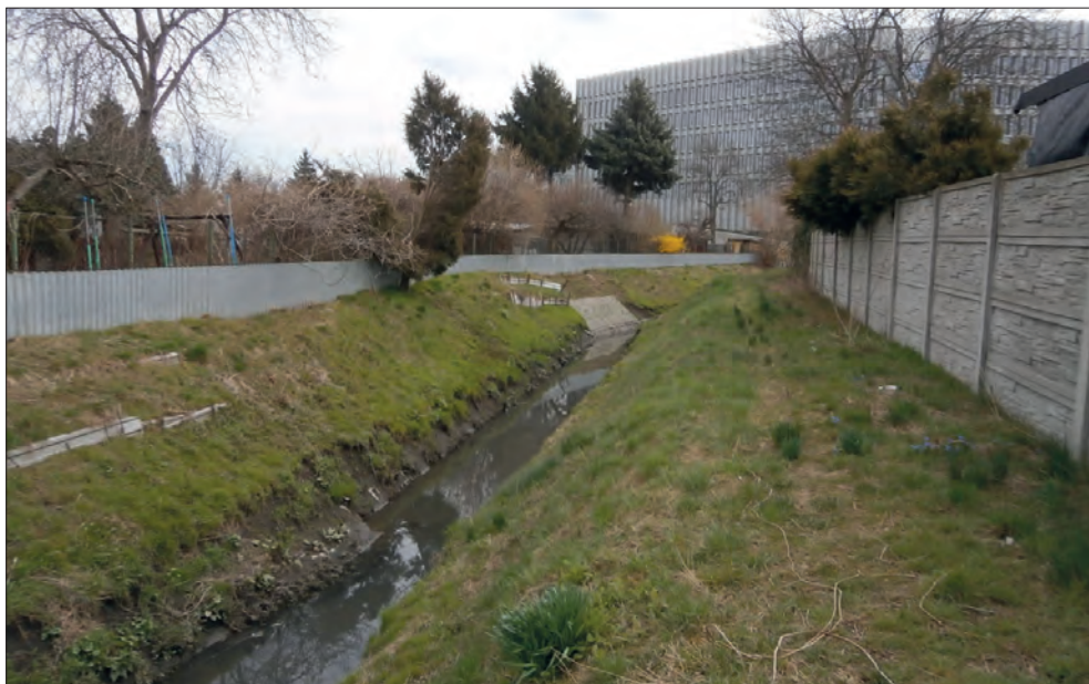
Sadurka na poziomie ulicy KOR (Okęcie), 13 kwietnia 2022, fot. B. Wierzbicka
