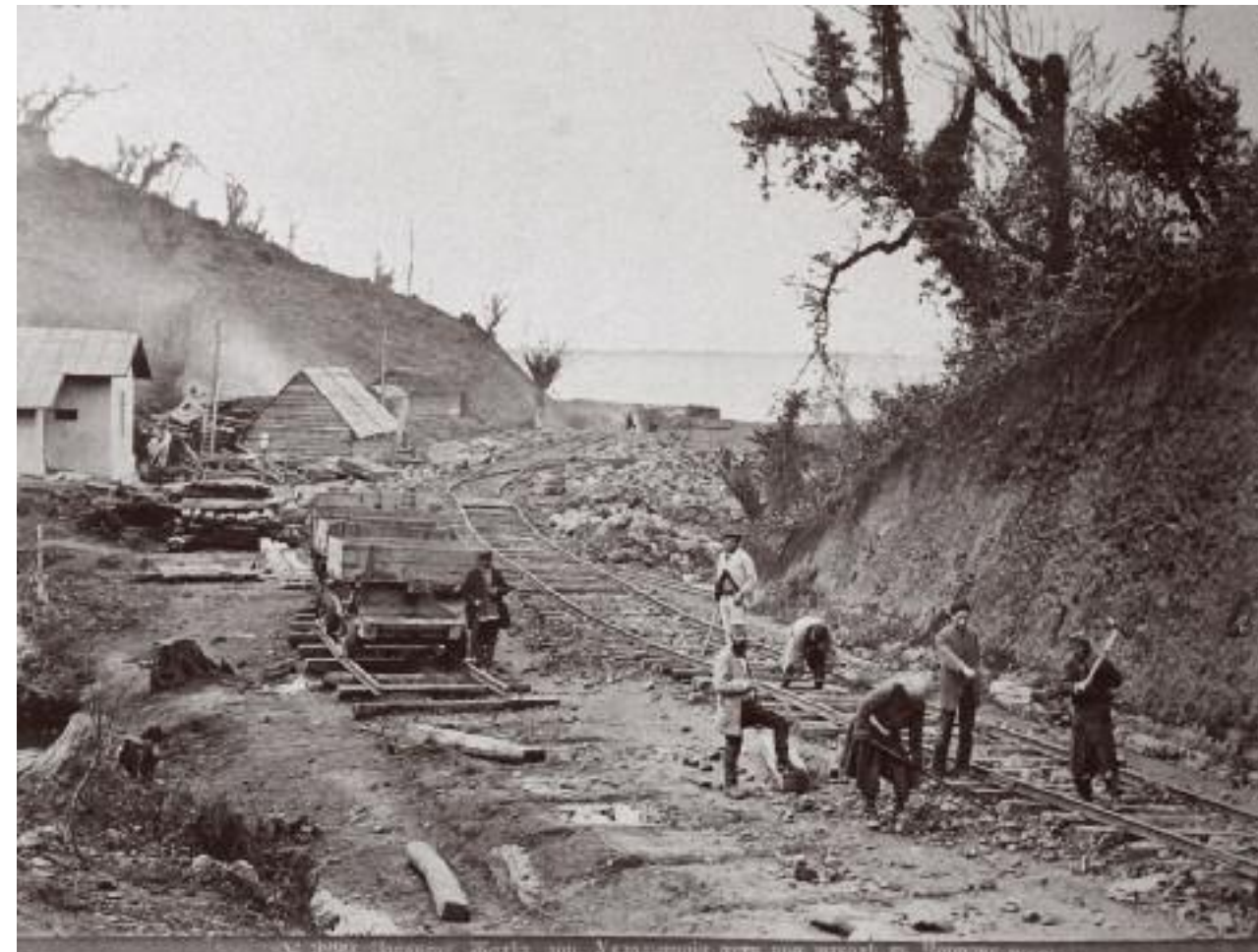
Prace przy budowie kolei nad brzegiem Morza Czarnego (1872-1900) (ANG)
