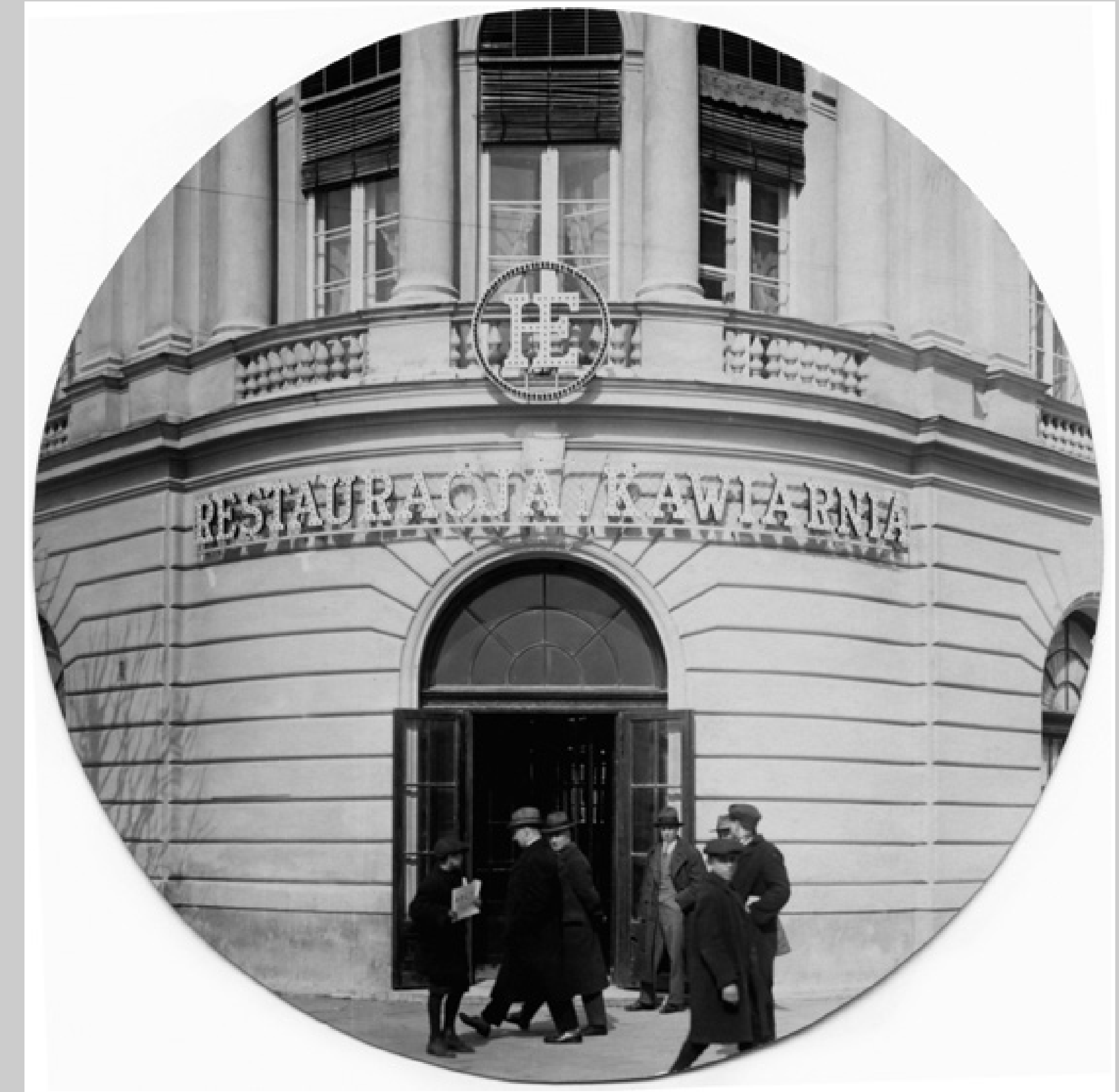
Wejście do restauracji i kawiarni Hotelu Europejskiego od strony placu J. Piłsudskiego, lata 30. NAC Entrance to the restaurant and cafe of the Hotel Europejski [European Hotel], from the J. Piłsudski square, the 30's. NAC
