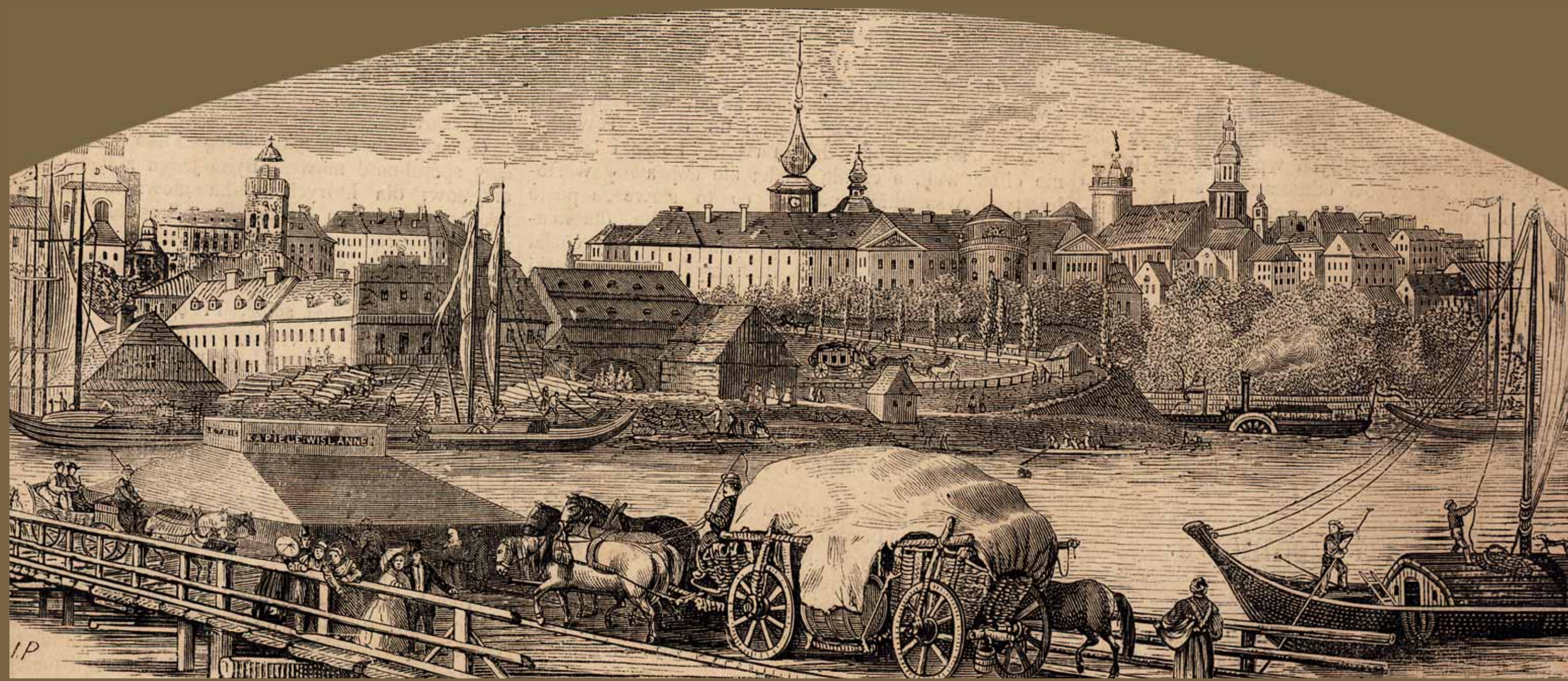
Most drewniany przez Wisłę, b.d., 201/I-191 | Wooden bridge over the Vistula River, no date, 201/I-191
