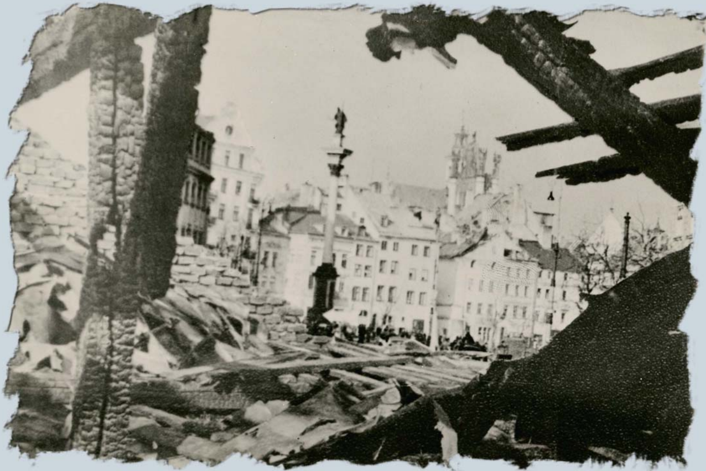
Plac Zamkowy (widok od strony kościoła św. Anny) — ruiny zniszczonych budynków, w głębi widoczna Kolumna Zygmunta i narożna kamienica na Pławnej ( Castle Square — view from the side of St. Anne's Church; ruins of destroyed buildings, Sigismund's Column and corner tenement house at Pławska Street visible in the background ), październik 1939, fot. NN, 72/1620/0/-/88
