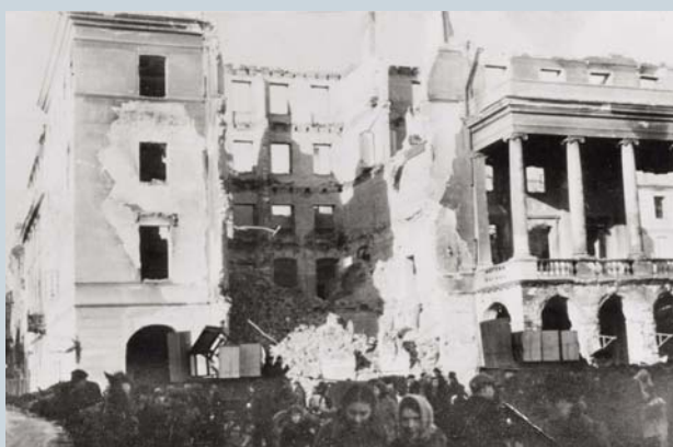
Ruiny pałacu Lubomirskich, ( Ruins of the Lubomirski Palace, September/October 1939 ), wrzesień/październik 1939, fot. NN, 72/1620/0/-83
