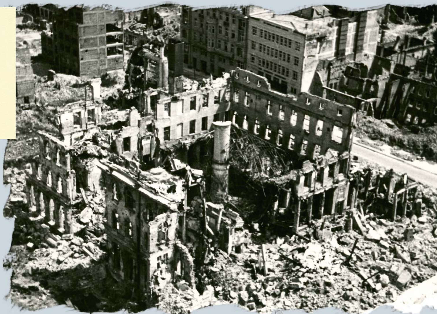
Zbombardowane domy przy placu Napoleona (obecnie pl. Powstańców Warszawy) ( Bombed houses at Napoleon Square, currently Powstańców Warszawy Square ), 1939, fot. NN, 72/1620/0/-135
