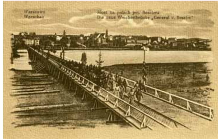
Most na palach gen. Beslera wybudowany przez Niemców obok odbudowywanego mostu Kierbedzia, po 1915, fot. NN, 1622/246 The gen. Besler's bridge on the piles built by the Germans next to the reconstructed Kierbedź Bridge, after 1915, photo NN, 1622/246
