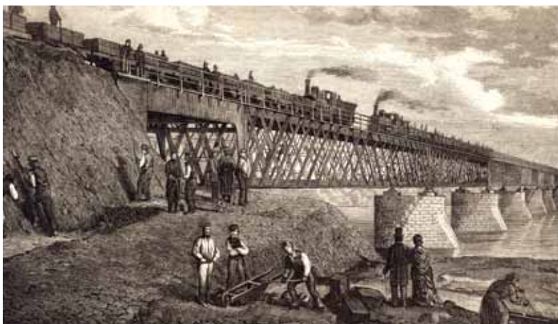
W trakcie budowy nowego żelaznego mostu przez Wisłę (przy Cytadeli), 1875, 201/I-201 During the construction of a new iron bridge across the Vistula River (at the Citadel), 1875, 201/I-201
