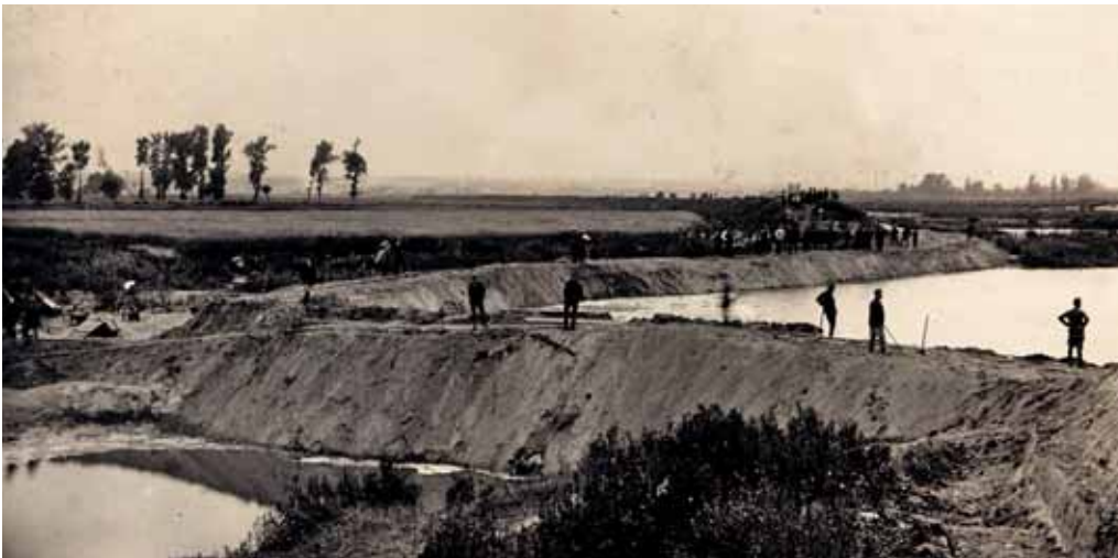
Prace nad Wisłą przy zabezpieczeniu terenu przed wylewem rzeki, 201/I-191
