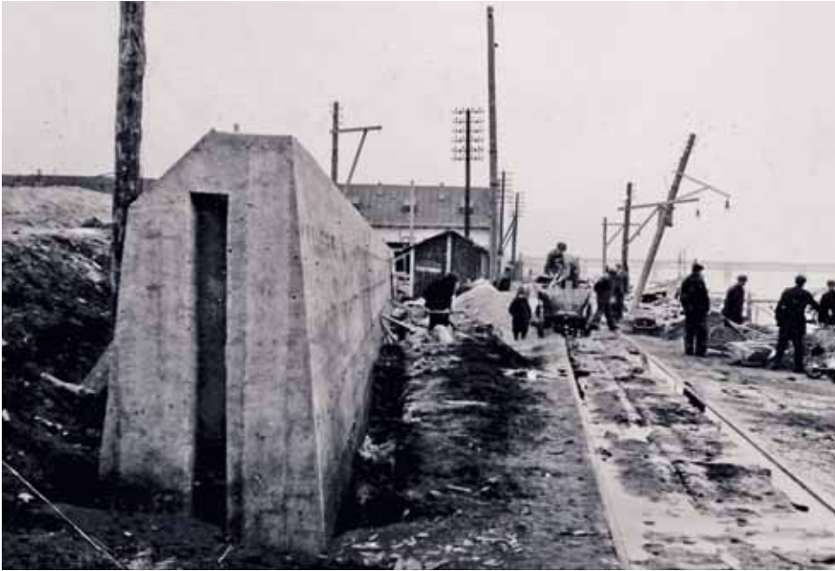
Budowa bulwaru na terenie Wybrzeża Kościuszkowskiego, 1935, 201/I-191 Construction of the boulevard on the Kościuszkowski Coast, 1935, 201/I-191
