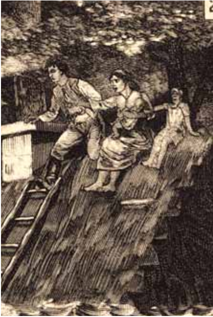
Powódź na Saskiej Kępie, 1884, 201/I-189 Flood on Saska Kępa, 1884, 201/I-189
