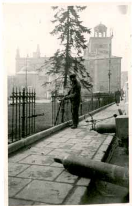
Realizowana na polecenie okupacyjnych władz niemieckich rozbiórka żeliwnego ogrodzenia wokół zamku królewskiego, w głębi sylweta kościoła św. Anny ( Demolition of a cast-iron fence around the Royal Castle was carried out at the request of the German occupation authorities, in the background the silhouette of the Church of St. Anna ), 1939, fot. NN, 72/1620/0/-/75
