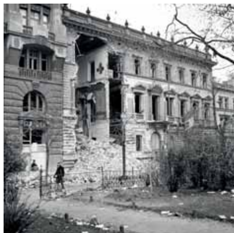
Zniszczony budynek ambasady włoskiej przy placu Dąbrowskiego w Warszawie, przed gmachem widoczny grób (Destroyed building of the Italian embassy at Dąbrowski Square in Warsaw, visible grave in front of the building), 1939, 72/3187/0/-/12
