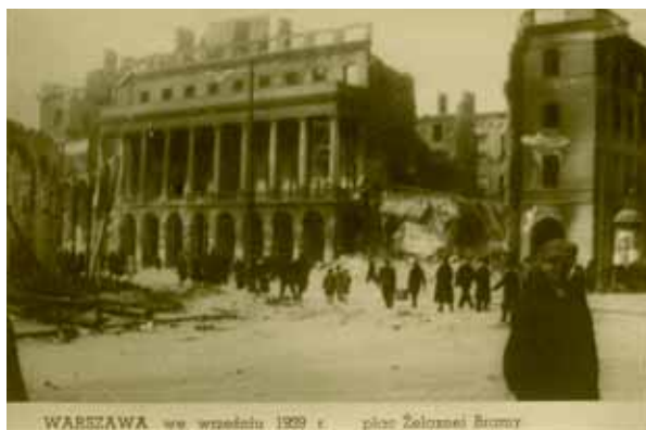
Warszawski plac Żelaznej Bramy ( Warsaw's Iron Gate Square ), wrzesień 1939,, fot. NN, 72/1620/0/-/175
