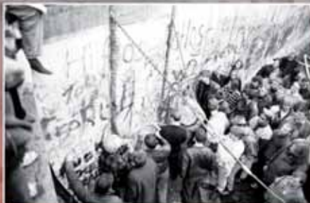
Elementy muru berlińskiego – systemy umocnień o długości 132 km (betonowy mur, okopy, zapory drutowe, miny), oddzielających Berlin Wschodni, stolicę NRD i niemieckimi zachodniej Brandenburgii od Berlina Zachodniego, istniejących od VII 1961 r. do XI 1989 r., 9 XI 1989 r., fot. , NAC, CAJ, rpgn. NACJ/CAJ/148213-29
