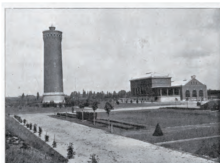
Widok Stacji Filtrów — budynek maszyn i wieża ciśnień.
