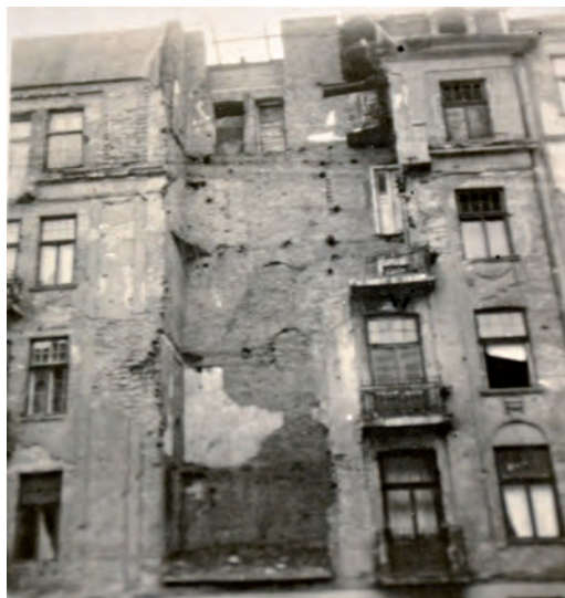
Uszkodzony fragment kamienicy przy ulicy Okrzei 28 (widok od Jagiellońskiej), 1945, fot. NN, ze zbiorów Archiwum Urzędu m.st. Warszawy.
