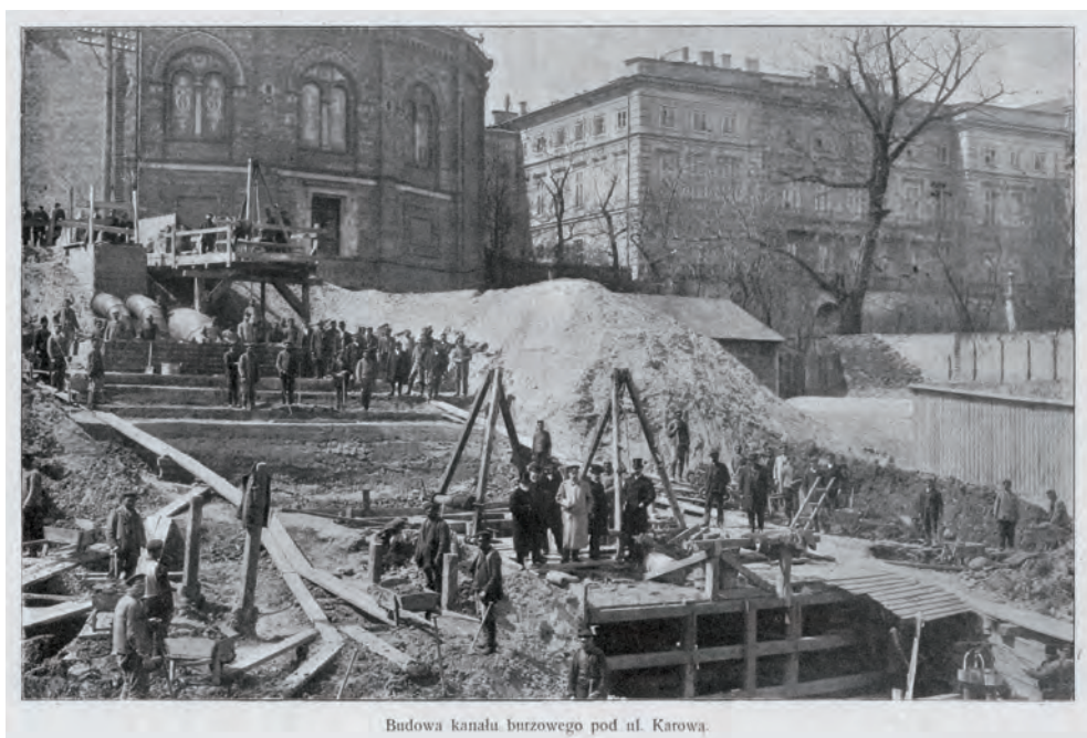
Budowa kanału burzowego pod ul. Karową.
