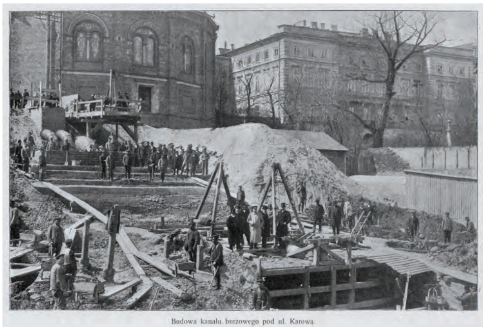
Prace przy budowie kanału burzowego pod ulicą Karową, 1911, ze zbiorów autora
