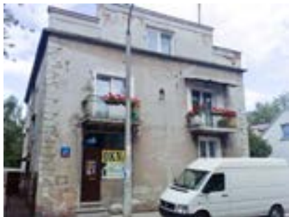
Kapliczki w elewacji budynków przy ulicach Zaliwskiego i Jarocińskiej, 14 III 2004 i 6 IX 2009, fot. A. Lipka
