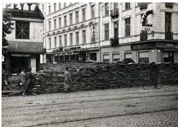
Ulica Marszałkowska u wylotu ulicy Chmielnej. Widok. Barykada z płyt chodnikowych i ziemi, na wierzchu wzmocniona workami z piaskiem
