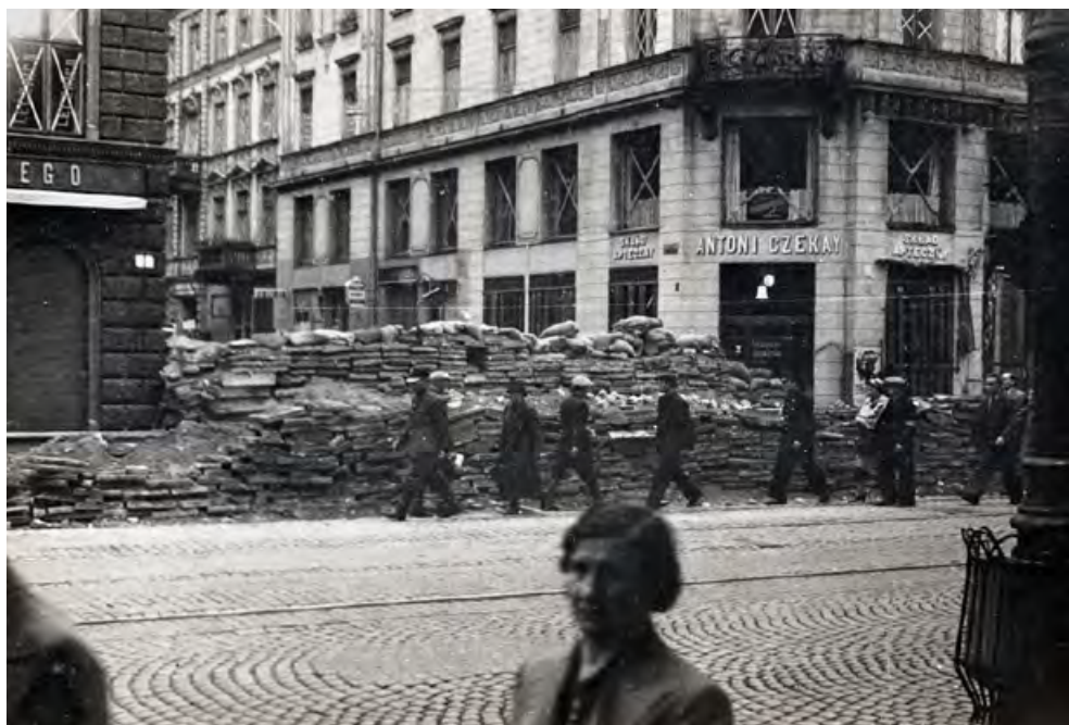
Ulica Marszałkowska u wylotu ulicy Chmielnej. Podwójna barykad z płyt chodnikowych i worków z piaskiem. Okna zabezpieczone paskami papierowymi, na murze widoczny plakat „Do broni”
