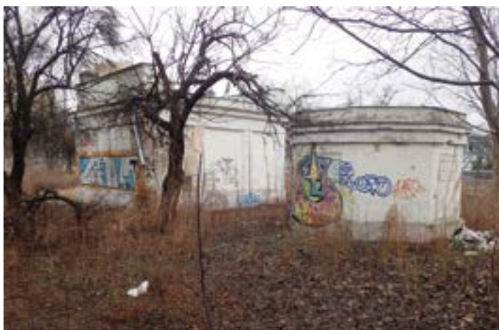
Widok studni zbiorczej ścieków i budynku przepompowni (na drugim planie)
