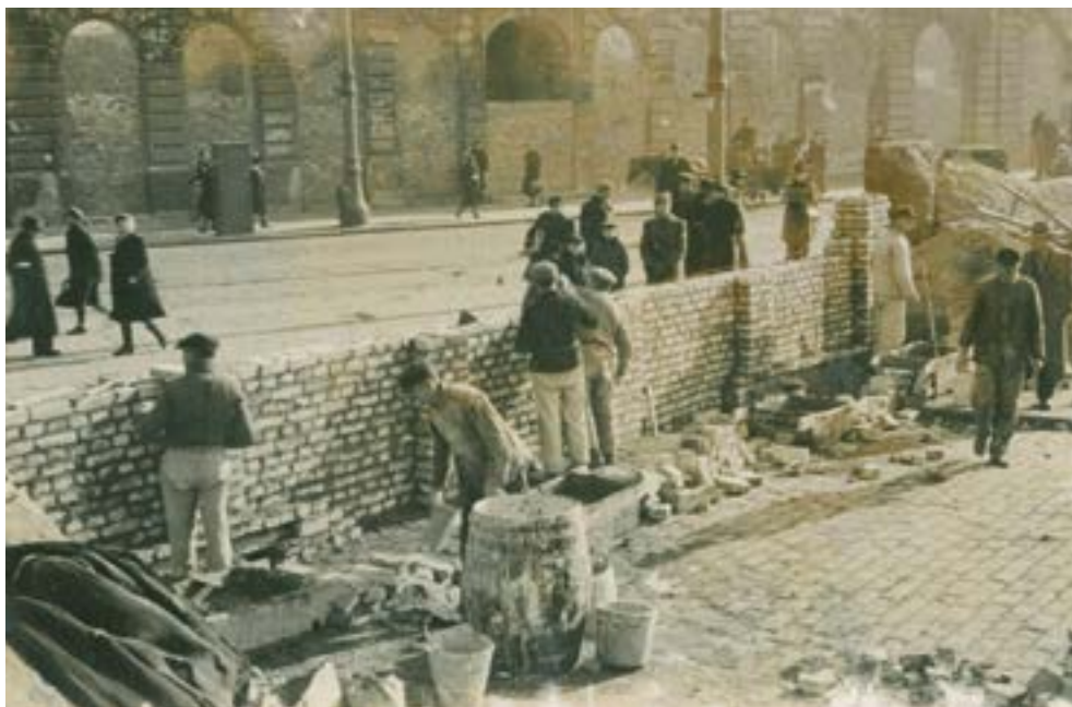
Budowa muru getta w Warszawie, ze zbiorów Archiwum Państwowego w Warszawie
