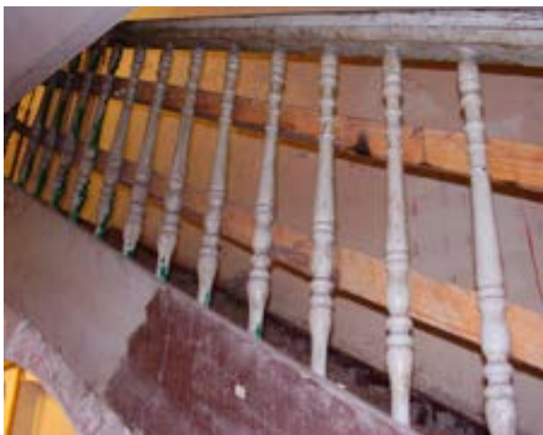
Ulica Stalowa 25 – balustrada przy drewnianych schodach w oficynie, fot. J. Sujewski
