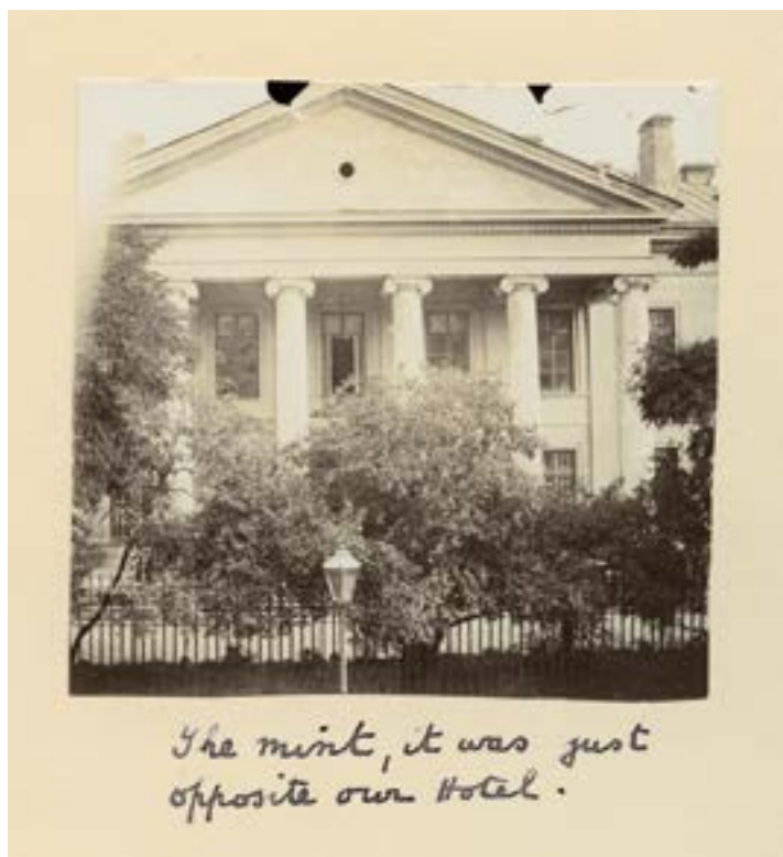
Ulica Bielańska – nowa mennica, rozebrana w 1907 r. pod budowę, zachowanego fragmentarycznie, Banku Polskiego
