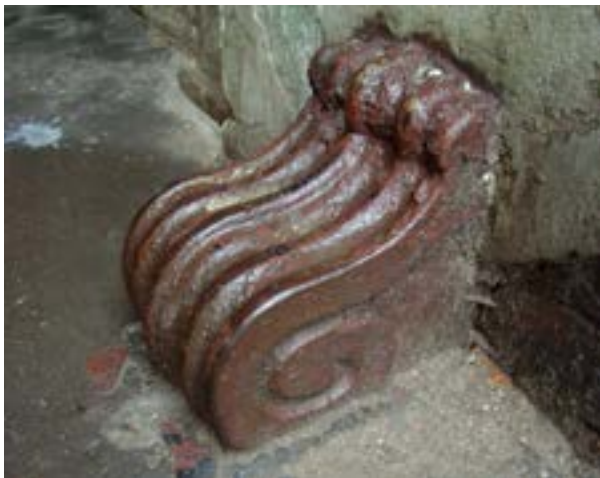
Ulica Stalowa 25 – żeliwny odbój w przejeździe bramnym, fot. J. Sujewski
