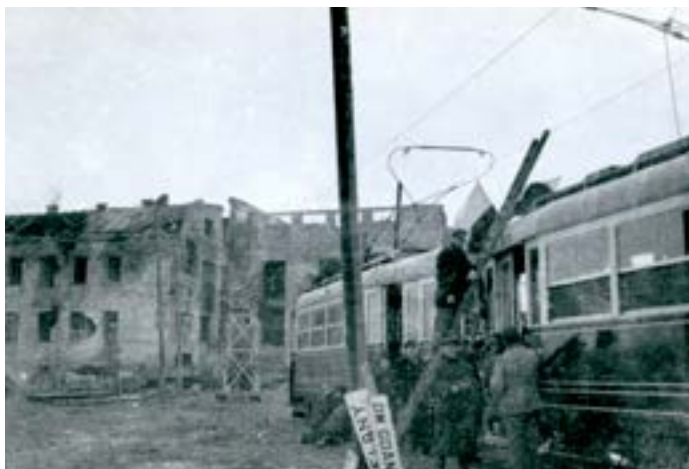
Remont linii tramwajowej, o słup oparte dwie tablice z napisami: „Most Gdański” i „Bielany”, 1945, ze zbiorów Archiwum Państwowego w Warszawie
