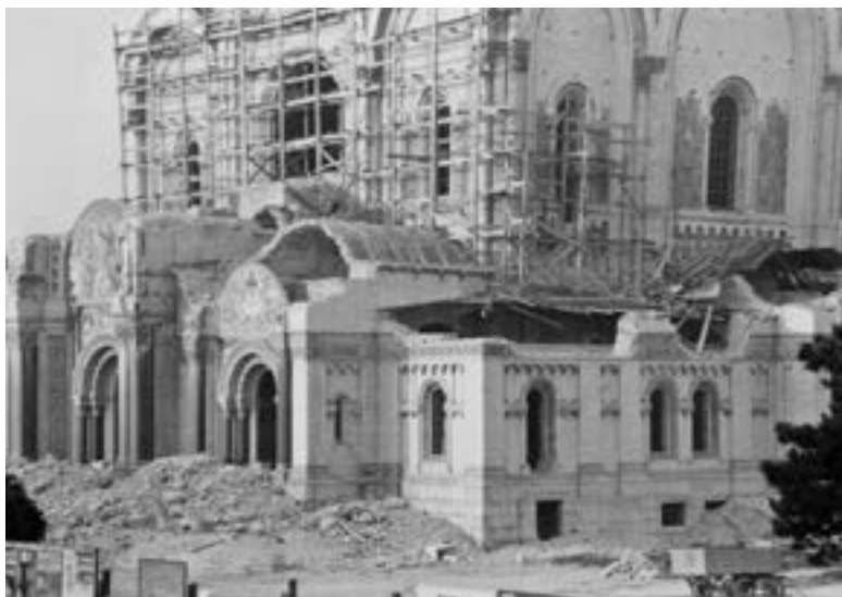
Rozbiórka soboru na pl. Saskim w latach 1924-1926
