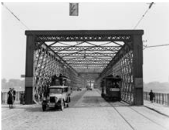
Most Kierbedzia, widok w kierunku Pragi. Stan po odbudowie z 1916 r., która była następstwem wysadzenia mostu przez wojska rosyjskie 5 sierpnia 1915 r. Wówczas na środku mostu ustawiono dwa przęsła, których konstrukcja utrudniała ruch
