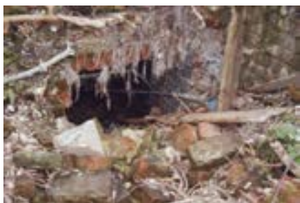
Wejście do zasypanej piwnicy kamienicy Różyckiego, 2014, fot. J. Sujecki
